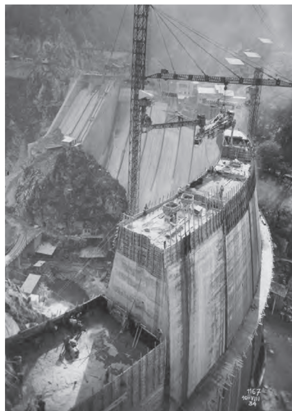
fig. 3. Barrage de Marèges en construction, 1931-1935. Archives Coyne et Bellier, photo Imbault (Mauriac).
